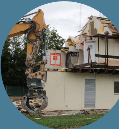
Flurstrasse 90 - Abbruch im 2022 nach 50 Jahren
